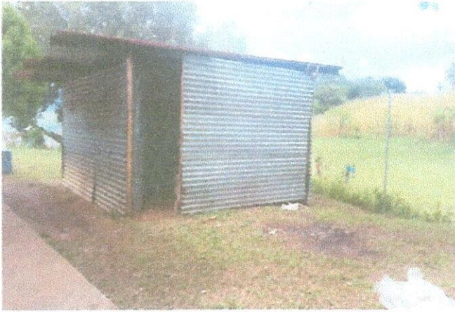
Foto1: Mejoramiento depuerta y ventana de módulo de cocina
