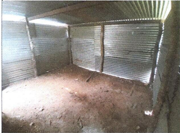
Foto 2: Mejoramiento de pared de cocina con mampostería de block.
