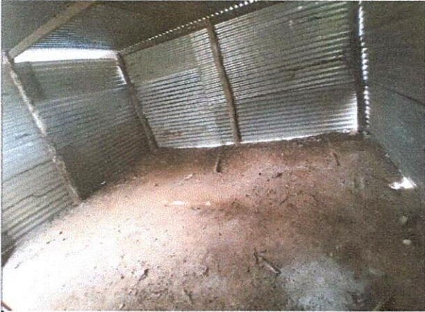
Foto1: Mejoramiento de piso cerámico
